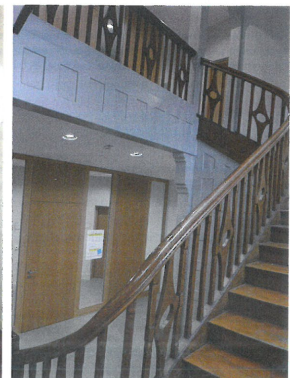
2 Blick vom Haupteingang in das Treppenhaus.
