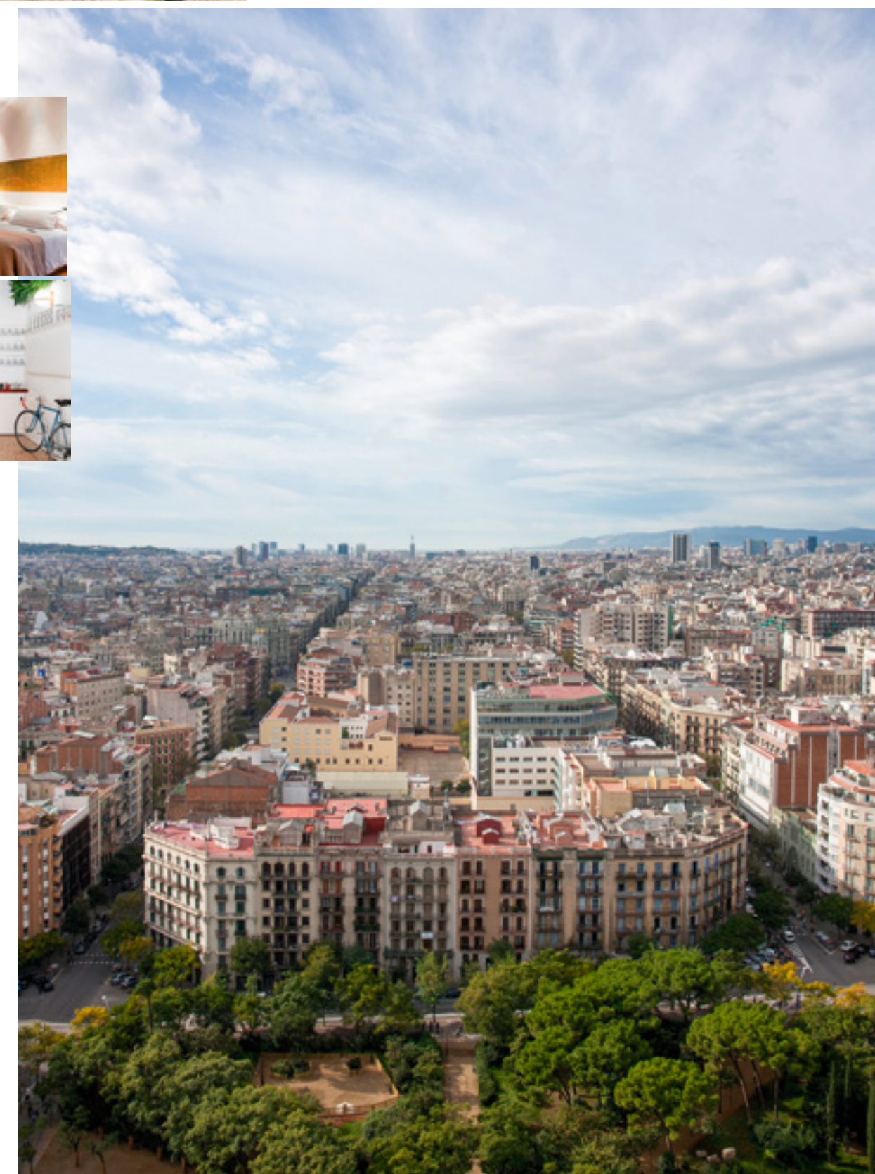
Grosses Bild: Der Stadtteil Eixample ist berühmt für seine Häuserblocks mit abgerundeten Ecken
