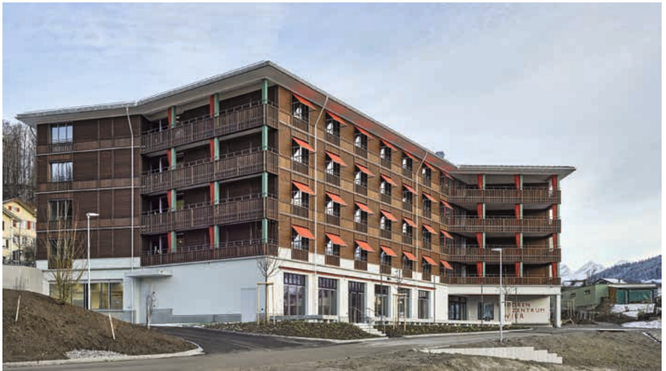
2 Das Schrägdach, die lineare Anordnung der Fenster und die dunkle Holzfassade sind als Reminiszenzen an die regionale Baukultur zu verstehen.
